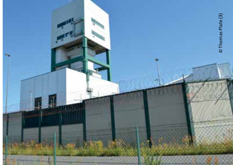
> Hier steht die Außenmauer noch.
