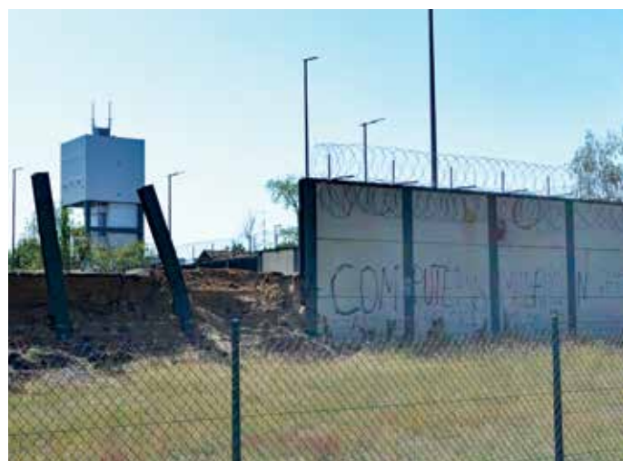
> Wie sieht Meinungsäußerung im Anlagenbereich zukünftig aus?
